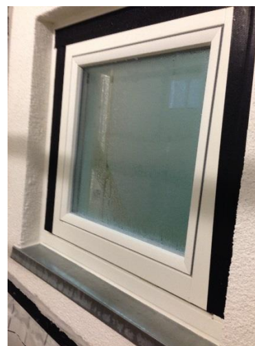
Billede 3. Udvendig side af vindues-konstruktion – den klimapåvirkede side.
